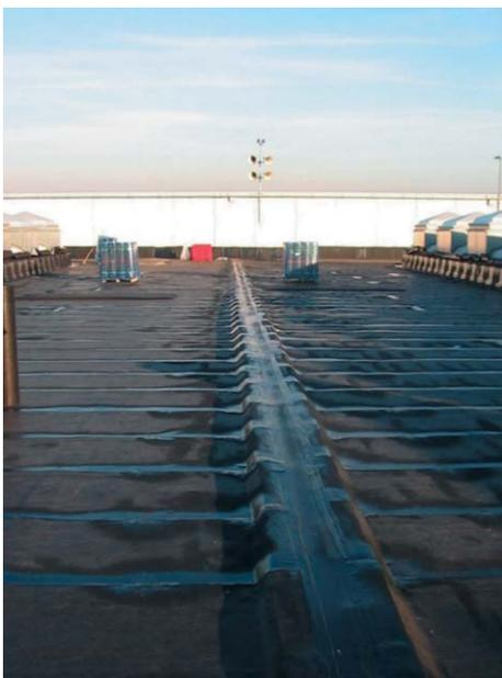
**Foto E** - Realizzazione del giunto di dilatazione impermeabile (visto dopo la posa del primo W negativo, eseguito con membrana elastomerica non armata).
