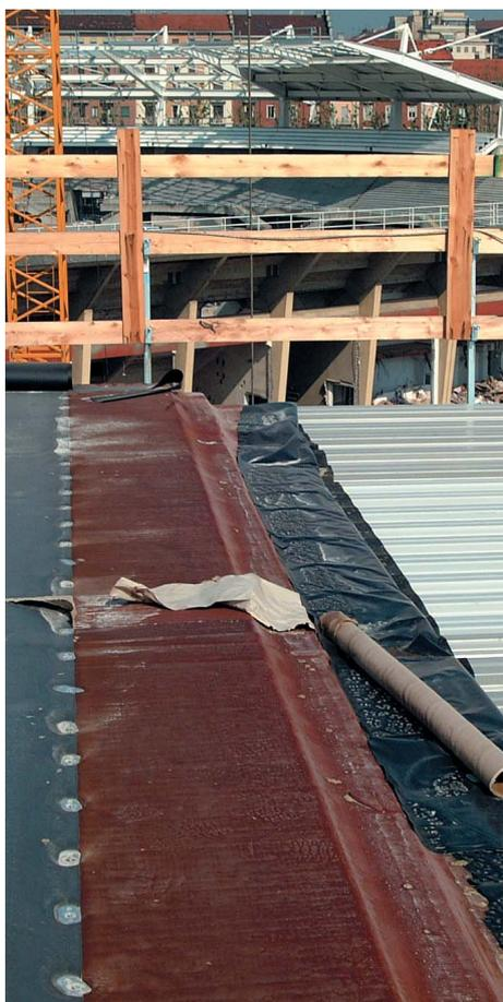
me polimero CLIO WW 6 dello spessore di mm 6 (peso di 7 kg/m<sup>2</sup>), armata con velo vetro, posato in totale indipendenza, con semplice sormonto dei teli.
