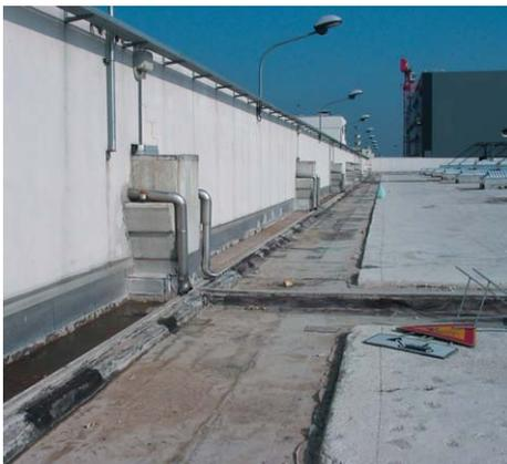
**Foto A** - Rimozione della pavimentazione e della fascia perimetrale della cappa cementizia, in corrispondenza dei risvolti verticali, per la messa a nudo della stratigrafia originale.
