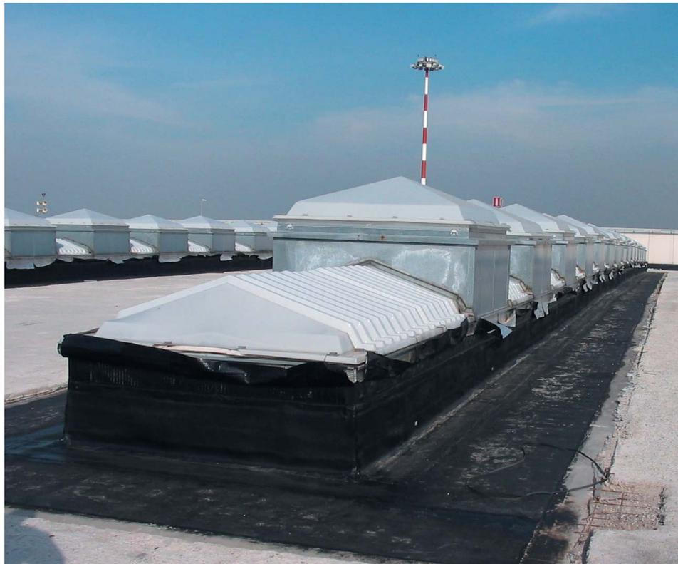
**Foto B** - Ripristino dell'impermeabilizzazione originale lungo la fascia perimetrale.
