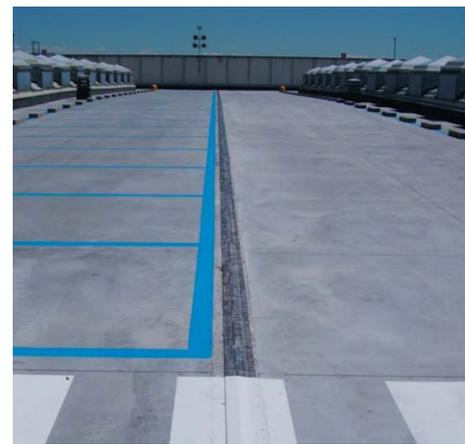
**Foto F** - Realizzazione del giunto di dilatazione a livello stradale con piastra scorrevole in acciaio inox.
