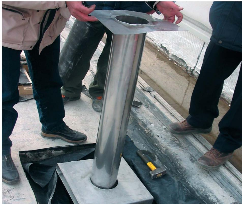
**Foto H** - Sistema di bocchettoni di scarico coassiali in acciaio inox collegati ai due livelli d'impermeabilizzazione.
