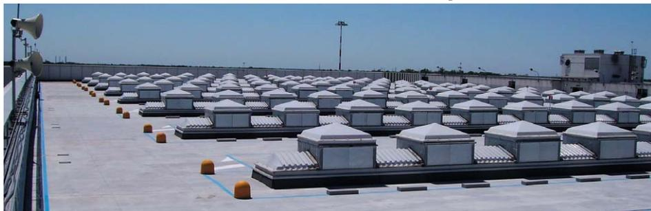
**Foto G** - Vista della copertura finita con pavimentazione in massetto industriale carrabile.
