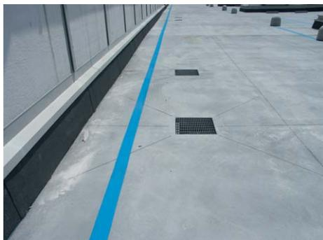
Foto 1 - Griglie ispezionabili a copertura scarichi posizionate lungo le fasce perimetrali esterne.
