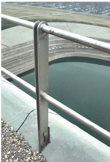
Ritto del parapetto pieghevole dopo la posa del rivestimento impermeabile della flangia.
