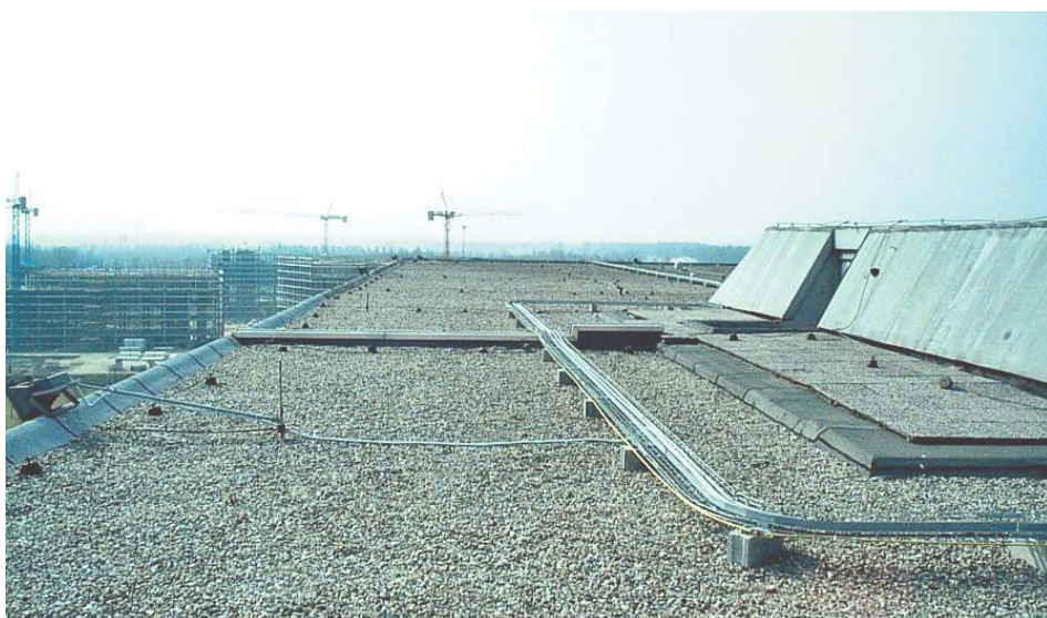
Vista della copertura prima dell'intervento di rifacimento.
