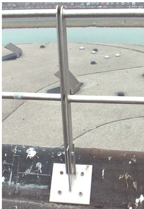
Ritto del parapetto pieghevole con flangia di fissaggio prima del suo rivestimento impermeabile.
