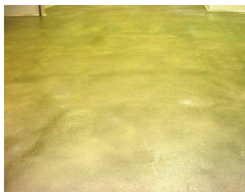
Rivestimento con pellicola a spessore
