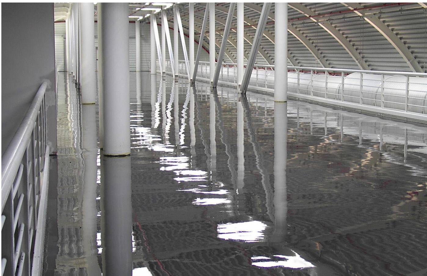
Ciclo protettivo ad alta resistenza chimica per contatto con alimentari a base di resina epossidica pura , senza solventi , omologato per contatto con vino , acqua e alimentari in genere .
